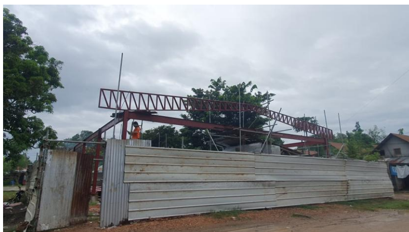
Widok ogólny na postęp prac przy budowie wieży na zbiornik
