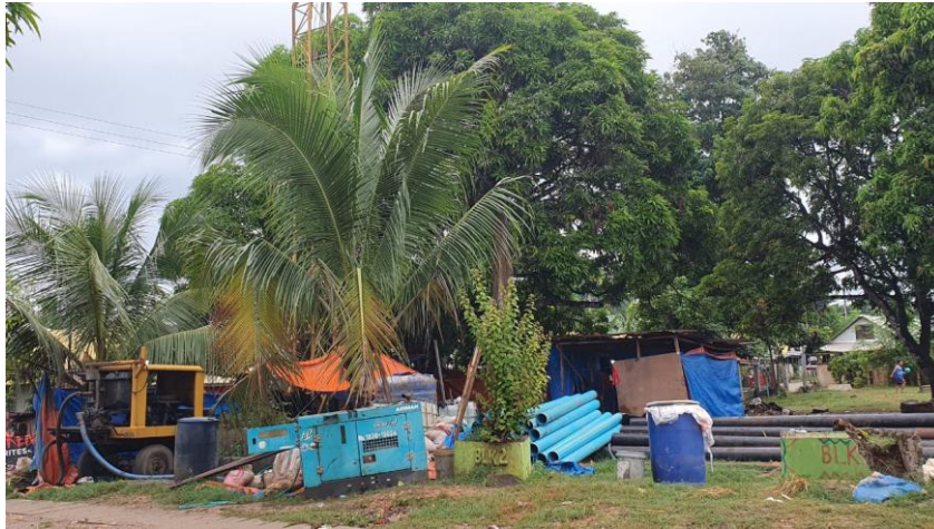
Sprzęt i materiały przygotowane do instalacji systemu wodnego
