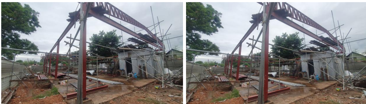
Budowa konstrukcji stalowej wieży pod zbiornik na wodę
