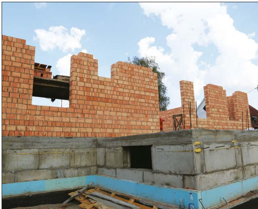
■ W czerwcu, na uprzątniętym placu, rozpoczęto budowę nowego domu.
